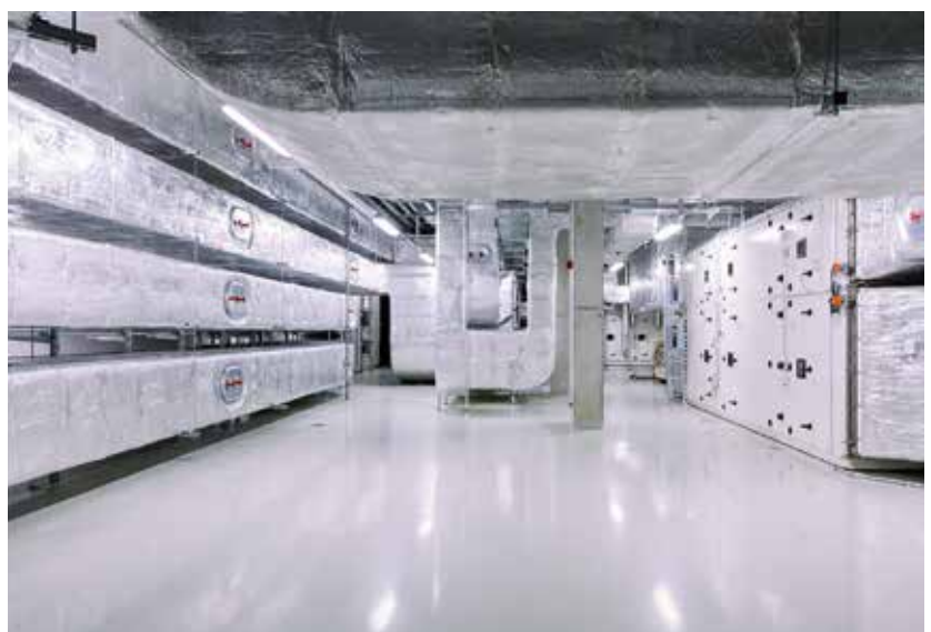
FIG. B Durch baumdicke Schächte strömt aufbereitete Frischluft in die Räume des Gebäudes.
