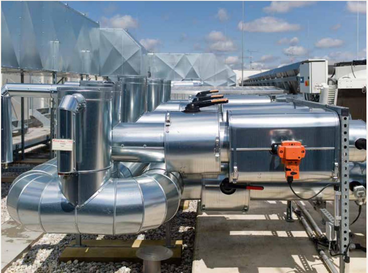
FIG. I Hier blitzen die feuerverzinkten Lüftungskanäle. Auch das Narkosegas entweicht hier oben, allerdings von Schadstoffen gereinigt, damit der Himmel über München sauber bleibt.
