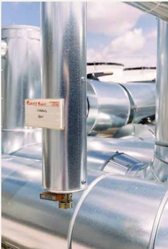
FIG. I Hier blitzen die feuerverzinkten Lüftungskanäle. Auch das Narkosegas entweicht hier oben, allerdings von Schadstoffen gereinigt, damit der Himmel über München sauber bleibt.
