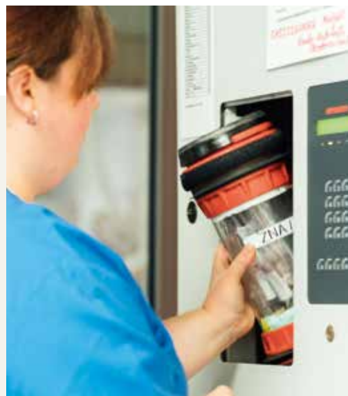
FIG. Lebensrettende «Bomben»: Die Blutproben aus der Notaufnahme fliegen per Rohrpost in Sekundenschnelle ins Labor.
