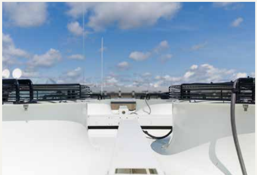
FIG. J Das Glykol für die Kälteanlagen wird auf dem Dach zurückgekühlt.
